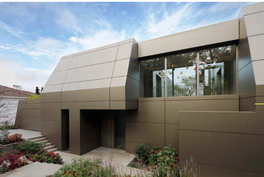
The entrance area with doors set deep in the façade contrasts with the side overlooking the garden, which opens out into the landscape. Der Eingangsbereich mit tief liegenden Türen kontrastiert die zur Landschaft geöffnete Gartenseite.
