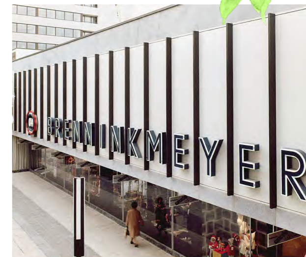
1969 Réalisation du premier petit projet de façade : C&A Brenninkmeyer à Leverkusen, Allemagne – un revêtement très simple avec des panneaux non formés
