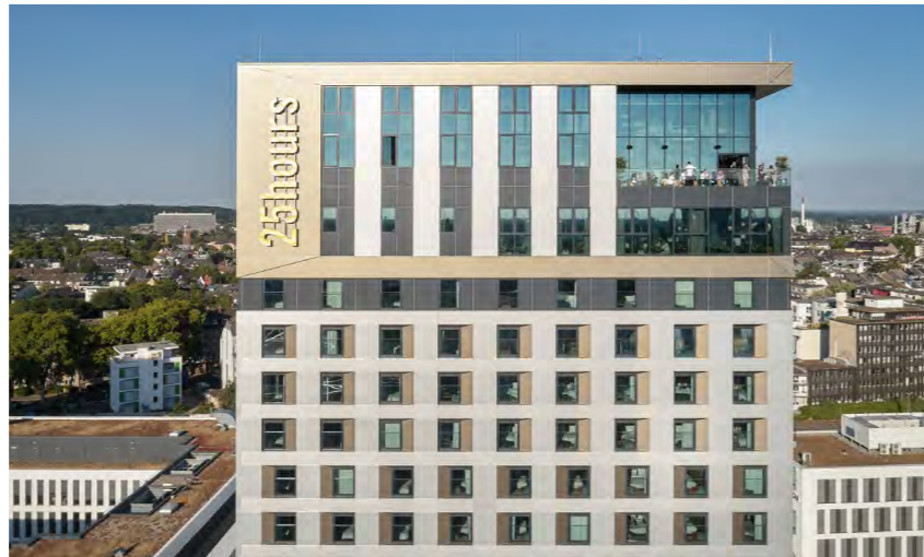
Hôtel 25hours à Düsseldorf, Allemagne DGNB Certificat or ALUCOBOND® A2 Anthracite Grey, Anodized Look C32 + C0/EV1 © Andreas Horsky
