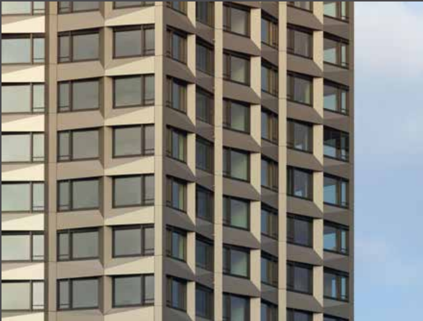
Die matt schimmernde Fassade aus ALUCOBOND® PLUS anodized look C31 mit ihrer warmen, neutralen Farbigkeit verändert sich dezent mit dem Licht. | Bild: Florian Licht
