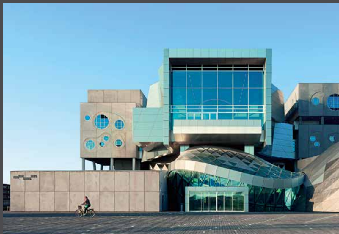
Die Fassade aus ALUCOBOND® PLUS Aluminiumverbundplatten in naturAL Brushed verleiht dem Gebäude einen individuellen Charakter. | Bilder: Duccio Malagamba
