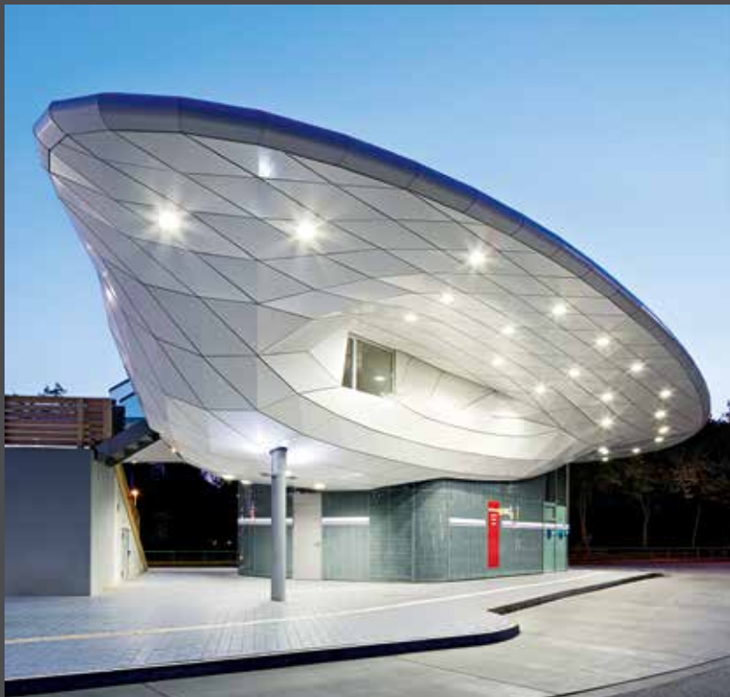
Das schwebende Flügeldach des Busbahnhofes Hamburg Poppenbüttel aus ALUCOBOND® PLUS Reinweiß. | Bild: archimages
