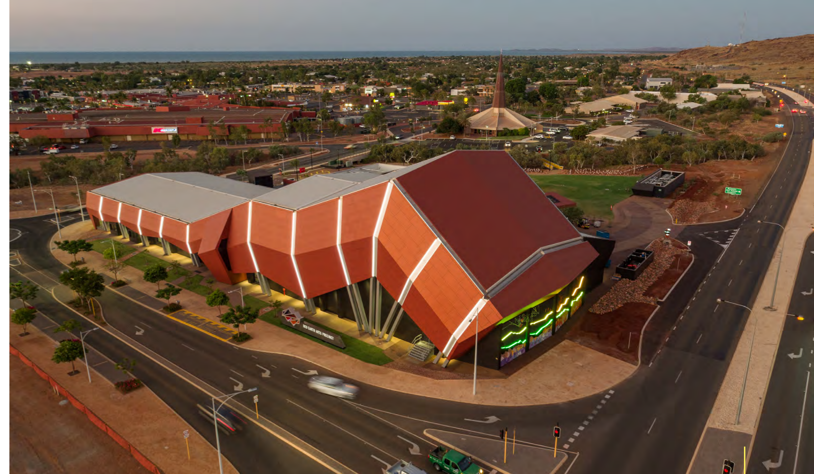
The steel roof with ALUCOBOND® panels looks like a scale armour. Its height is dictated by internal spatial requirements. Das Stahldach mit ALUCOBOND®-Platten wirkt wie ein geschuppter Panzer. Seine Höhenentwicklung folgt dem Raumbedarf im Innern.
